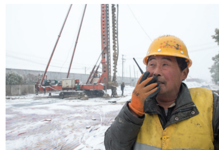
大雪中的合肥长丰县商合杭高铁建设工地。 周诚/图
