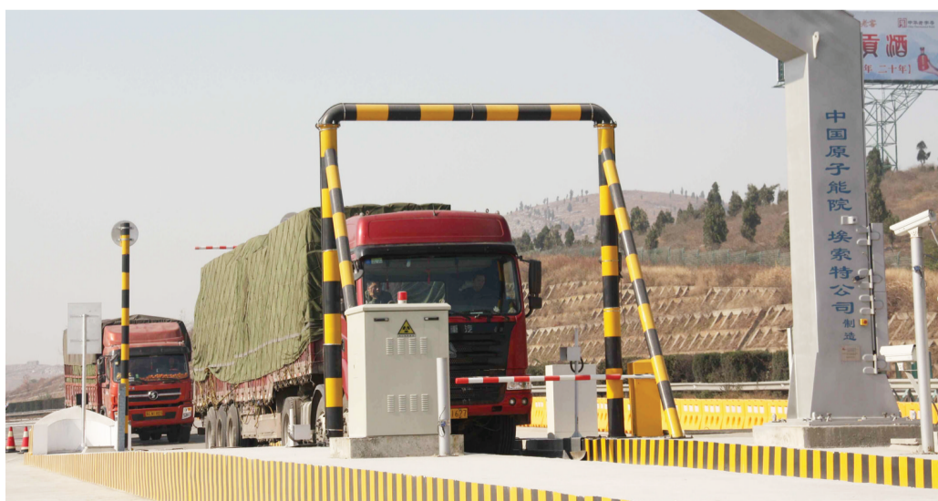
连霍高速皖苏站设置绿色通道自动化检测设备,提高绿通车辆检测效率和检测精准度,大大降低物流成本
