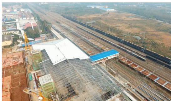
近日,安徽六安高铁站主站房最后一榀屋面网架杆件精确安装就位,标志着由中国中铁四局集团承建的六安站改扩建工程主体结构完成,全面进入装饰装修阶段。■ 中新社
