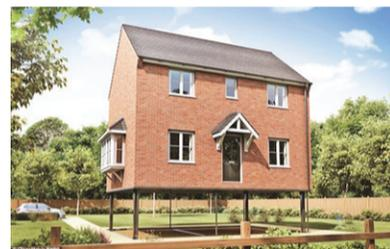
近日,英国设计师公布了一款带有可升降功能的三居室房屋。这种房屋重达65吨,底下有八个千斤顶。在遇到洪水时,整个房子可在5分钟内,抬升约1.5米的高度。开发人员说,目前他们已经取得实验许可。如果实验成功的话,这样的房子可以建在洪水频发的地方,家具再也不用泡水了。
