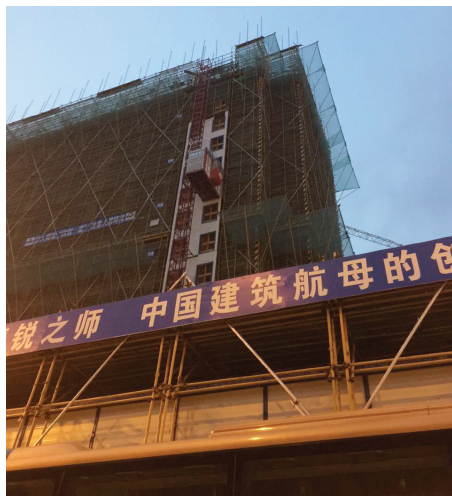
铜陵路与裕溪路交叉口一工地在施工
