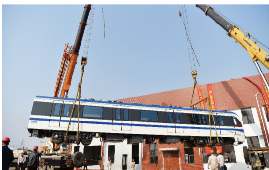
正在吊起首趟列车放入轨道
