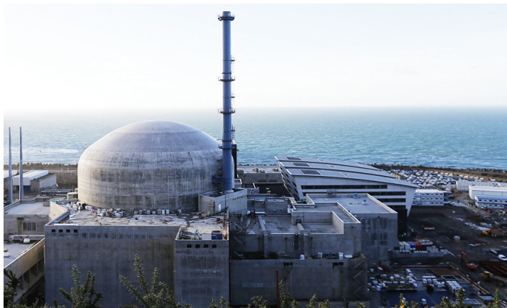
法国弗拉芒维尔核电站
