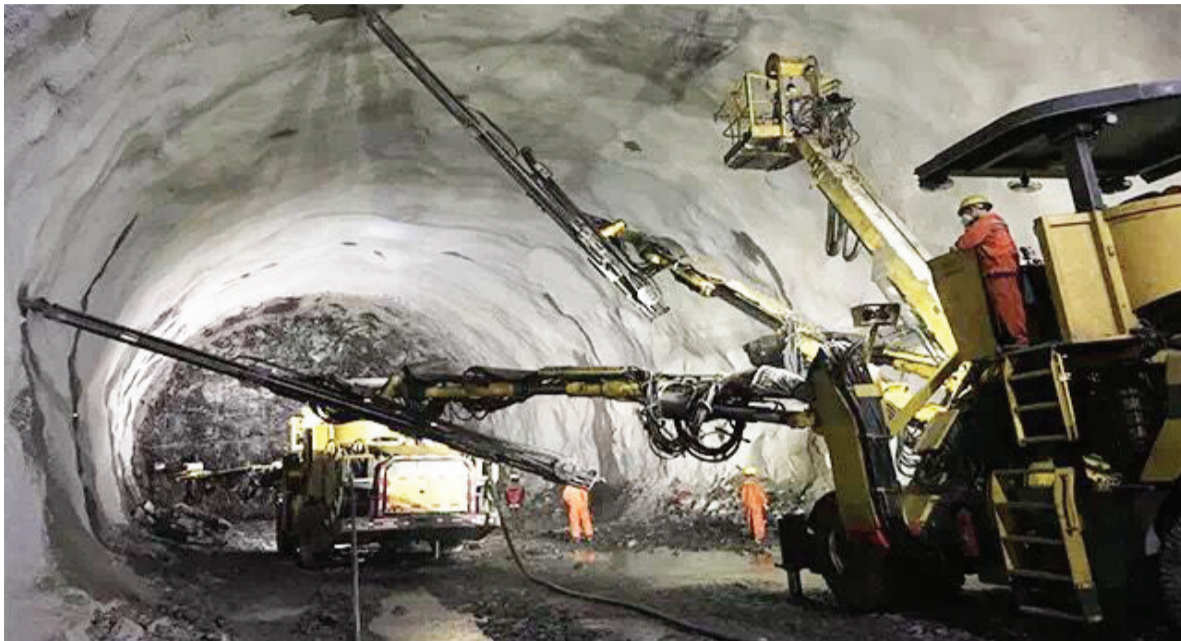
建设中的天目山隧道
