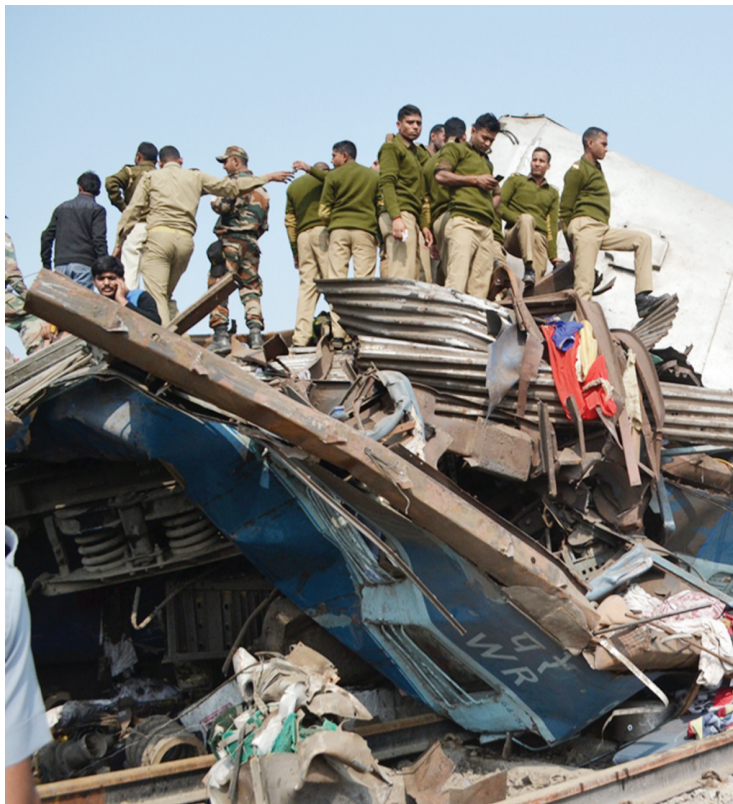
救援人员在火车脱轨现场工作
