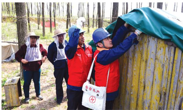
肥西县供电公司员工在为蜂农更换低压用电线路。
