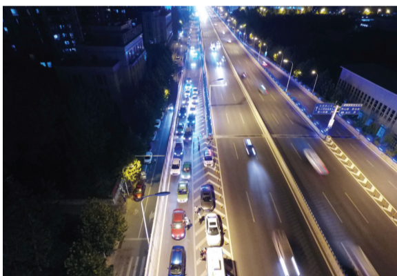
合作化路高架黄山上桥口航拍现场
