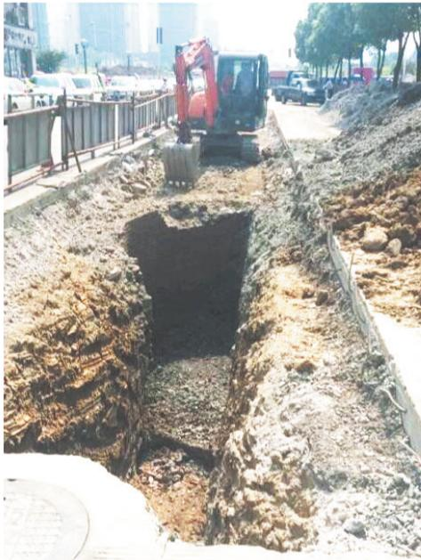
今年入汛以来,合肥市遭遇多次强降雨袭击,合肥市颍河路、扶疏路、龙门岭路等区域道路、小区、学校出现短时积水。市场星报、安徽财经网记者从新站、高新区了解到,对该区域排水管网系统调查后发现扶疏路排水管道出现损坏,变形的管道长约30米。据悉,目前变形的管道正在进行更换处理。谭泳舟 记者 沈娟娟 文/图
