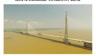
8月10日上午10时10分,随着望江至东至长江公路大桥主梁最后一条焊缝施工完成,目前世界上最大跨度的叠合梁斜拉桥——望东长江公路大桥顺利实现合龙,为年底建成通车奠定了基础。望东长江大桥项目北接安庆市望江县,南连池州市东至县,为八百里皖江上游的第一座长江大桥,是国家高速公路网 G35(济南至广州)中最为便捷的过江通道,也是安徽省"四纵八横"高速公路网中"纵四"的重要组成部分。
