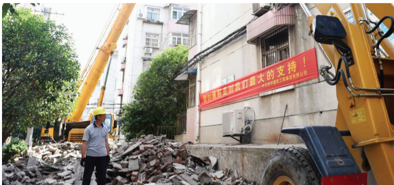
老旧小区整治现场
