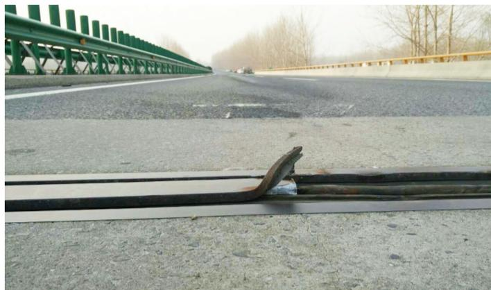
3月16日下午,淮北交警高速一大队接到多名驾驶员报警称,行驶至符夹桥路段时突然爆胎。巡逻民警立即赶到事发地点,发现路边已停了11辆受损汽车。经检查发现,桥面小型车道内伸缩缝的钢梁不知为何断裂翘起,钢条像一把利刃一样立在桥面,变成一个“破胎器”,所过车辆只要轧到,就会立即爆胎。民警立即对该车道进行了封闭,并引导车辆从旁边有序经过。民警一直值守到晚上19时,并会同路产部门将翘起的钢梁熔断,使路面恢复平整。
