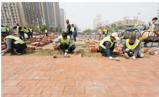
工人正在铺设环保道板砖
