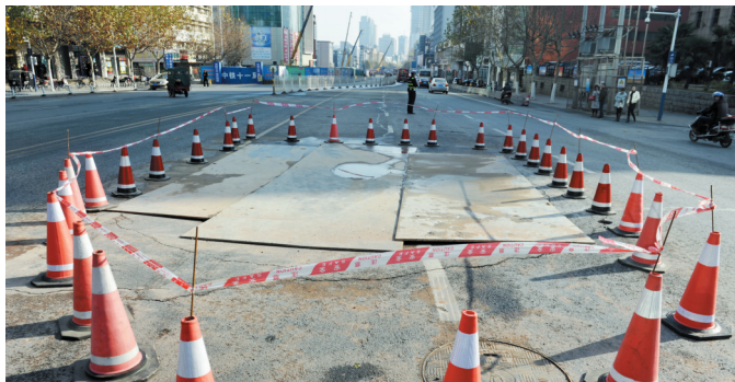
现场铺上钢板并拉起警戒线
