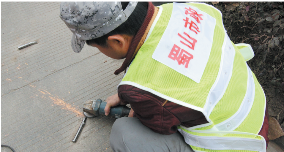
地面上的钢筋要用手持砂轮切割机才能清除
