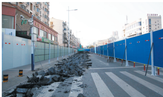
临泉路和蒙城路交叉口,工程机械已进入施工场地
