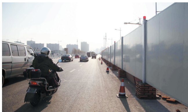
四里河路和临泉路交口的非机动车道被封闭
