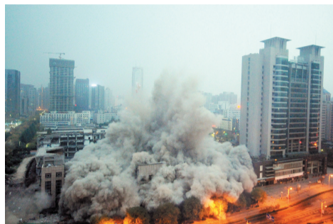
11月15日,西安市高新二路16号高层建筑定向爆破拆除获得圆满成功。据了解,该大楼地下1层、地上26层、高118米。
