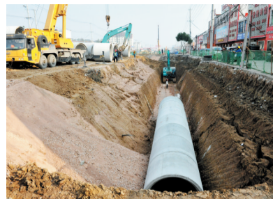
合淮路(西二环至新G206)改造基础设施工程全面展开,目前正在进行地下管道的铺设,预计明年8月完工建成通车。本次改造的合淮路南起西二环路,北至新G206国道,全长约23公里,沥青混凝土路面。 记者 倪路/图
