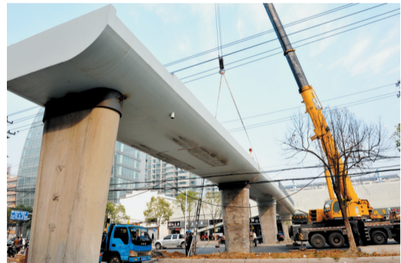
昨日,合肥望江路省立儿童医院门前人行天桥开建,这是南半部沿线首个吊装的天桥,完工后将有效缓解该处交通拥堵现状。据悉,望江路沿线将新建10座过街人行天桥,增设300多个停车位,内侧设13对路中的岛式公交停靠站,有望成为一条“靓丽干道”。 记者 倪路/图
