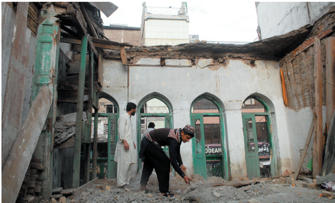
在巴基斯坦白沙瓦,人们在强震后检查房屋废墟
