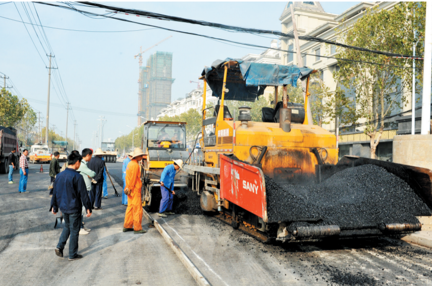
合肥望江路改造工程进展顺利,东段部分路面开始铺沥青。昨日上午,在徽州大道东侧,一车车的沥青,正缓缓地倒进铺路机中。 记者 倪路/摄
