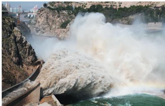
9月6日，黄河刘家峡洮河口“黄龙飞泻”。当日，黄河刘家峡洮河口排沙洞水下岩塞被爆破排除，裹挟着大量泥沙的水流从排沙洞出口喷涌而出，形成壮观的“黄龙飞泻”场面。
