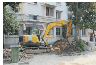
瑶海区长淮街道七里塘社区的王槽恢复楼、金鑫南村小区,列入该区2015年12个小区综合整治计划。日前,承建单位已进场施工。
