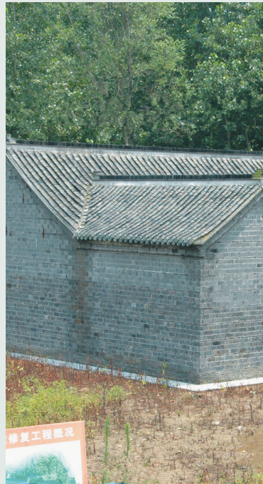
中共皖东工委旧址重建工程
