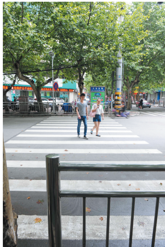
近日,一条“奇葩”人行斑马线出现在滁州市天长东路与建设路交口,这条斑马线的两端竟然直接被道路护栏挡住,如果路人沿着斑马线过马路,必须直接翻越护栏才能行走。当地市民称,这样的设计让人看不懂。 宋卫星 记者 胡昊
