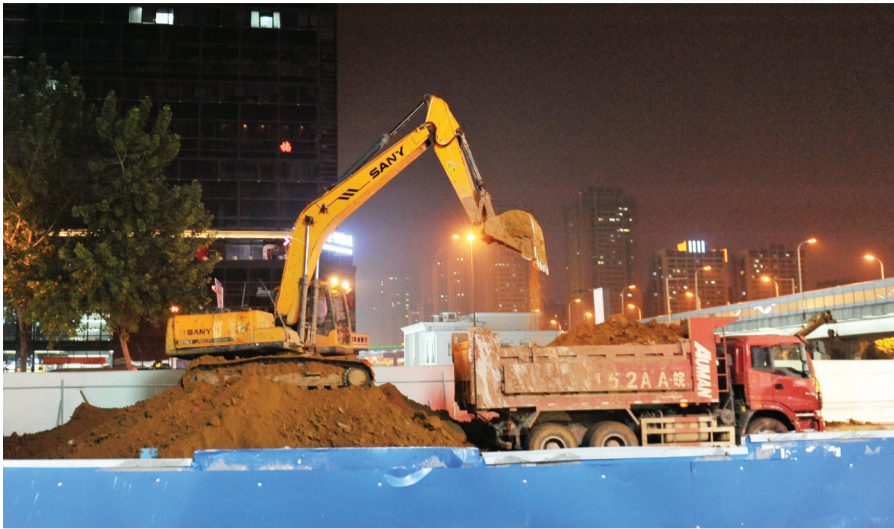
地铁一号线太湖路站施工现场很热闹
