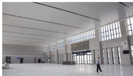
候车大厅的装修已基本完成
