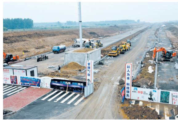
合肥习友路向西延伸(大龙山路-将军岭路), 进一步对接肥西。据悉, 习友路是东西向重要干道, 延长工程道路长约3公里, 宽为60米, 设计标准为城市快速路, 总投资7000万元。
