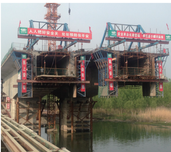
济祁高速涡阳段涡河特大桥施工现场
