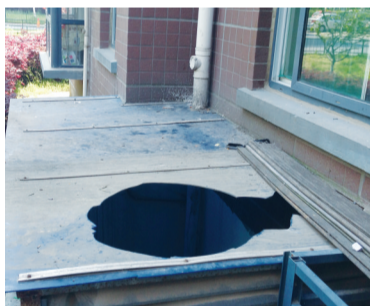
事发通风井的玻璃盖板露出一个大窟窿
