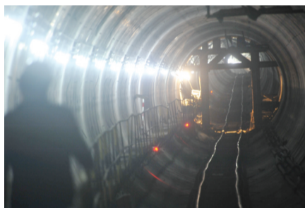
手工开挖隧道处
