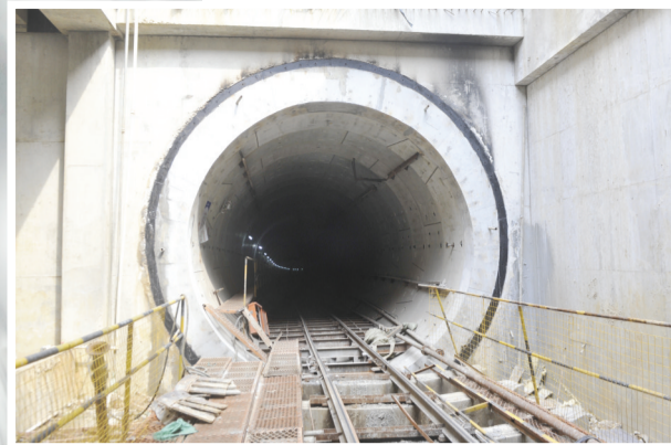
轨道车出入口
