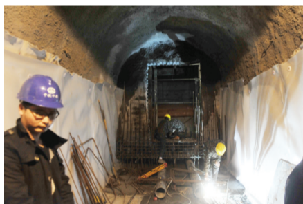
手工开挖的隧道
