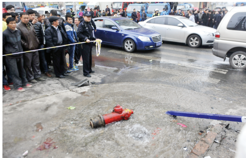
事发现场交通标和消防栓都被撞断
