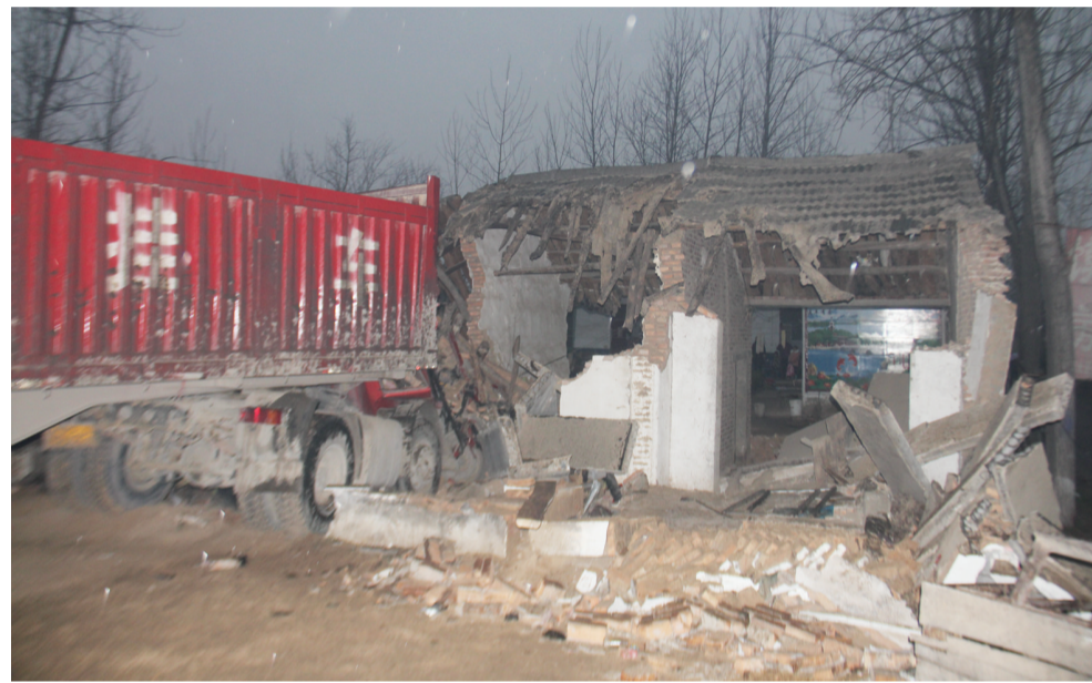
货车失控冲塌民房现场
