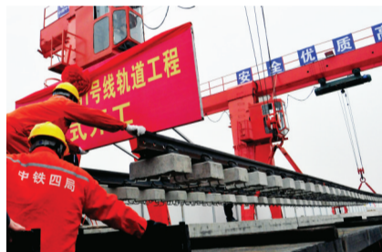
施工人员吊运轨排
