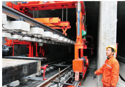
吊运轨排进入地下道口
