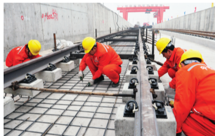
铺轨施工现场
