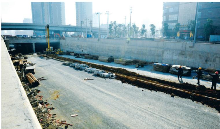
合肥望江西路下穿火车站立交工程主车道框架已全部浇筑完成，本月底开通主车道，春节前放行人行道。望江西路以西四座独立框架桥下穿火车站，机动车道连续下穿翡翠路、火车站和西二环，行人和非机动车道通过坡道接入西二环与翡翠路交口，全长约1.4公里。
