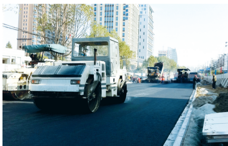
现场摊铺沥青
