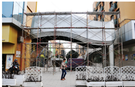
正在装修的街口
