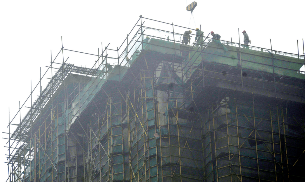
部分地块已经复工
