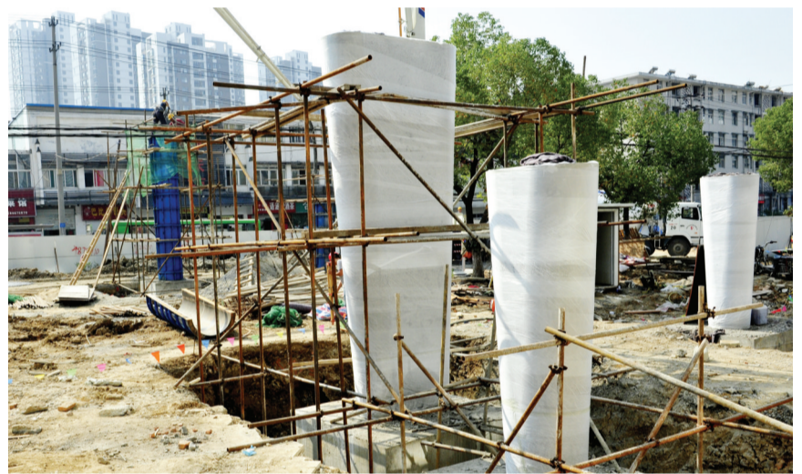
在合肥望江路改造工程现场,新建的10座人行天桥也在同步施工,目前大部分混凝土桥墩已浇筑成行。望江路为合肥市区重要的东西向主干道,沿线将设13对路中的岛式公交停靠站。为此,在新建天桥的同时,现有的人行天桥、地下通道也将实施改造。记者 倪路/图
