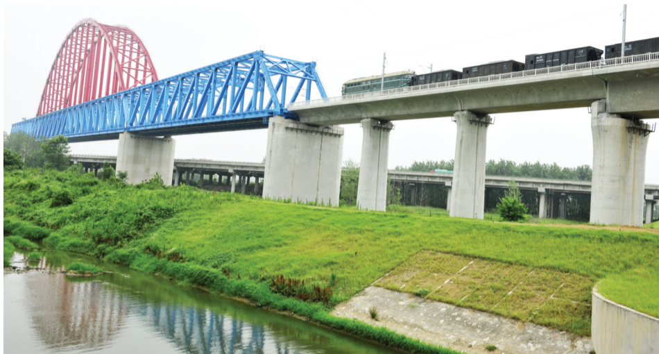
正在建设中的合福线 记者 倪路/图
