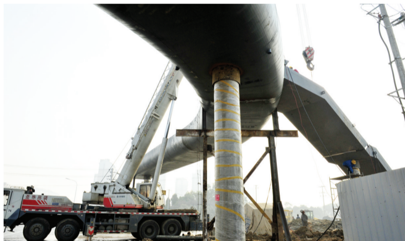
昨日, 在合肥庐州大道与龙川路交口, 一座环形人行天桥开始吊装。合肥南站投入运营后, 该路段车流量会很大, 天桥的建成市民过马路会更安全便捷。同时, 沿线还将在黟县路、南环路交口各新建一座人行天桥。 记者 倪路/图
