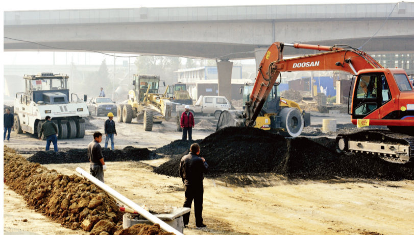
近日，合肥庐州大道(龙川路-繁华大道段)建设工地一片繁忙，大型工程车正在加紧平整路面。据悉，庐州大道位于合肥高铁南站东侧，建成后将成为公交车进出高铁南站的主通道，该路有望于10月底通车。 记者 倪路/图
