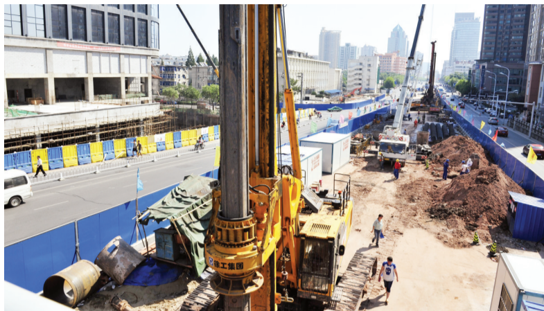
轨道交通建设现场
