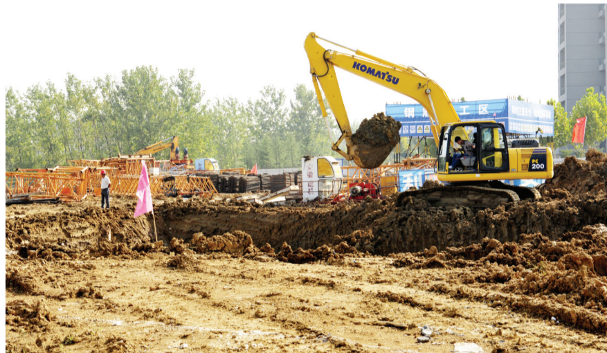
市场星报记者昨日获悉,合肥市老年公寓二期工程开工建设,将新增412张床位。公寓二期位于魏武路与李湾路交口东北角,总建筑面积约2.77万平方米,服务中心将设有乒乓球、网球场等设施。
