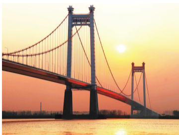
马鞍山长江大桥
