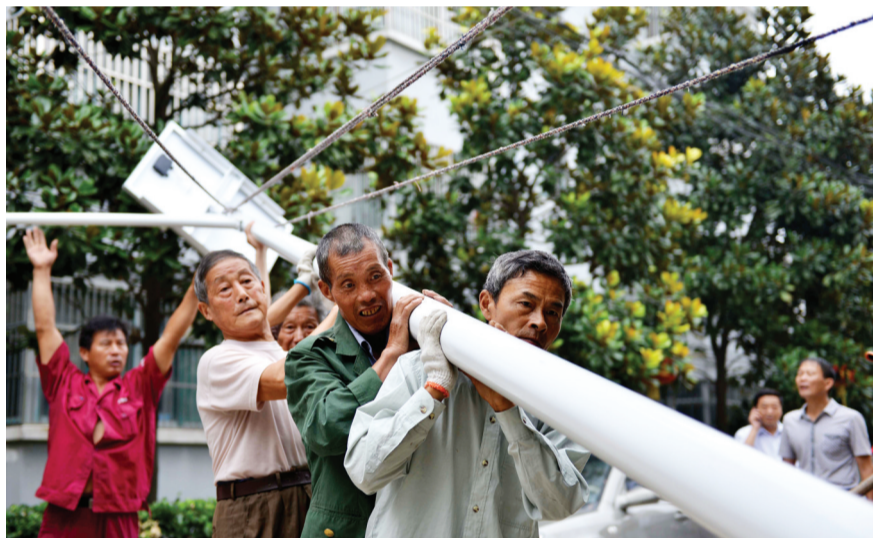
在开展群众路线教育实践活动过程中,合肥市大杨镇王敦社居委积极争取资金为辖区没有路灯的老旧小区统一安装了太阳能路灯,既方便群众生活又提高社区居民的安全感。图为近日,工作人员在安装太阳能路灯。 冬生 记者 倪路/图
