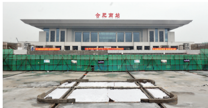
高铁南站正在完成最后的施工
